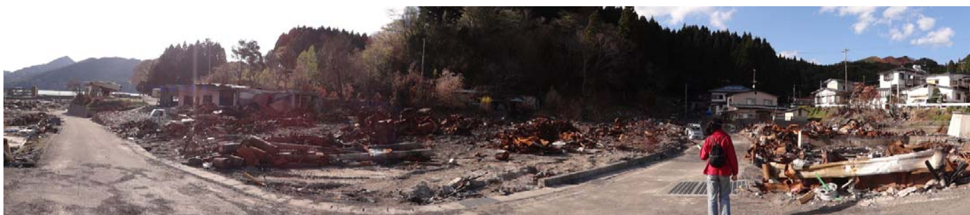
写真4 延焼範囲の中央から北西を見た火災①の焼け跡（2011年5月2日撮影） (左側敷地内の焼失していない車は火災後の移動なし。右側の道路際の車は、鎮火後移動している。)
