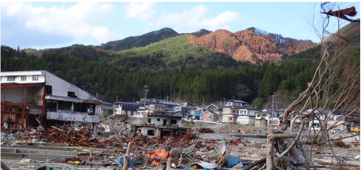
写真13 火災②の南西側（海側）から見た状況（2011年5月2日撮影） （左端の漁村センターの右側（山側）の外部に焼毀痕がある。内部はほとんど燃えていない。）
