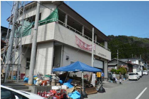
写真17 山田町消防団第2分団屯所
