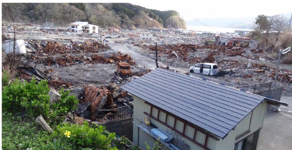
写真5 延焼範囲の北東側角から見た火災①の焼け跡（左手前は1933年三陸津波後造成した高地集落の宅地） (崖にそって住宅が津波後も2棟建っていたが焼失した。右側の道路際の車は、鎮火後移動)
