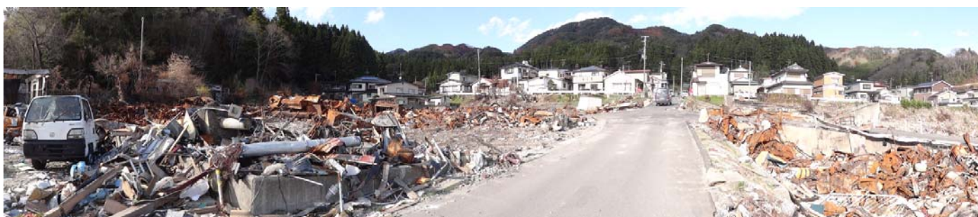
写真2 延焼範囲の西側（海側）から見た火災①の焼け跡 （画面右側手前にあった塗装店が津波で画面左側の山ぎわ付近へ流され、そこから出火したとのこと。）
