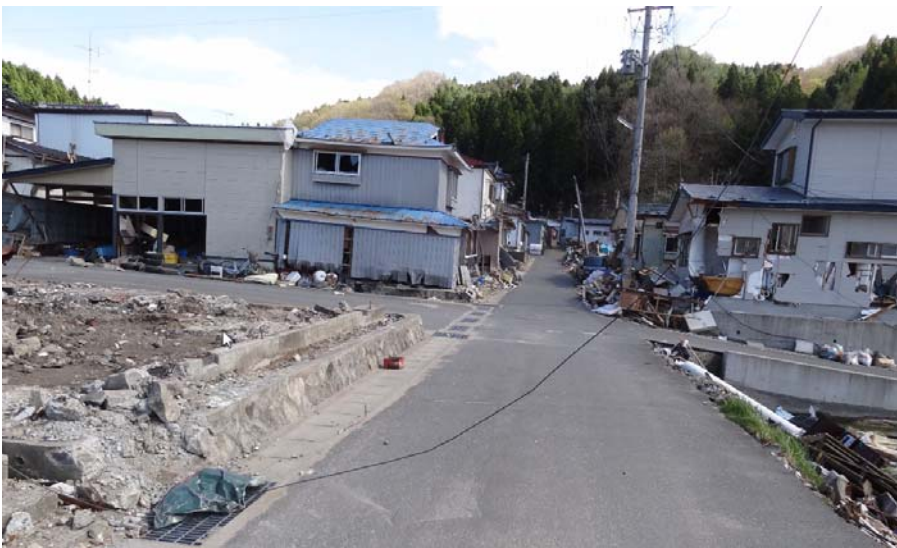
写真 10 火災②の南西角の焼止線の状況（2011年5月2日撮影）（左手前の街区が全焼した。）
